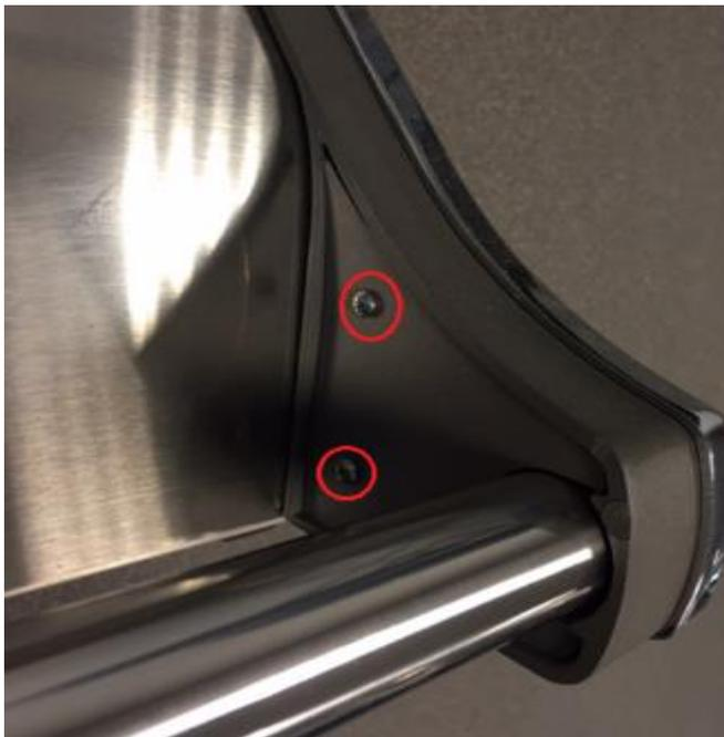
Nun auf der linker und rechter Seite zwei Schrauben von der Griffabdeckung lösen.
