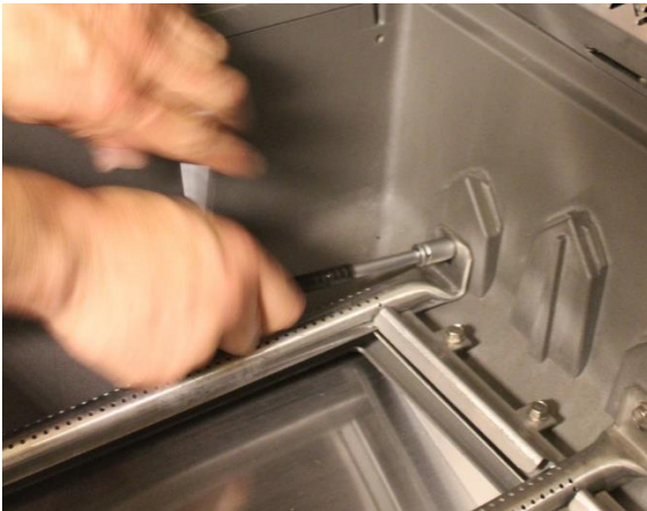
5 Luftklappenschrauben lösen
