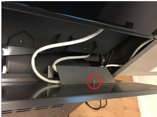
Die Zündbox ist unter einem Schutzblech montiert. Dieses können Sie durch lösen der Schraube entfernen.
