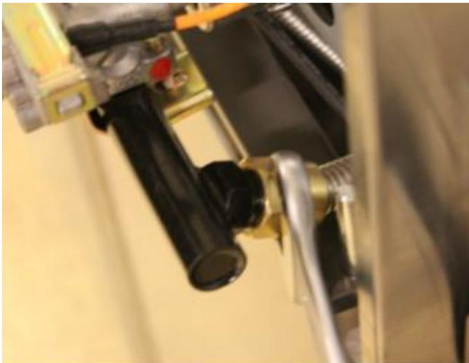
Jetzt kann in umgekehrter Reihenfolge die neue Gasbaugruppe montiert werden.
