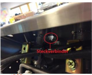
\* Bei der RSE Reihe die Verkabelung für die LED Beleuchtung lösen und alle Steckverbinder von der Rosette trennen.
